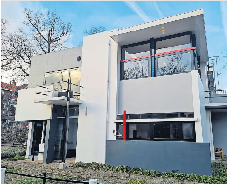
Schon von außen außergewöhnlich: Das Rietveld-Schröderhaus in Utrecht.
